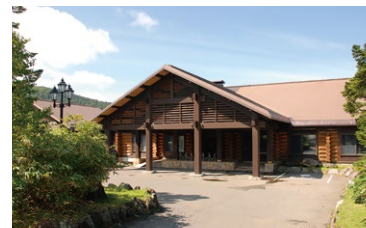
八甲田ホテル(キシラデコール施工)
