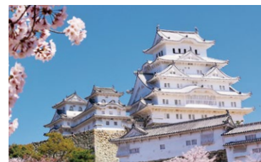
姫路城(キシラモン施工)
