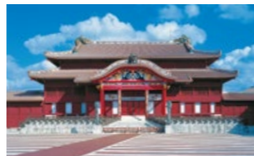
冲绳首里城 (用XYLAMON施工)
